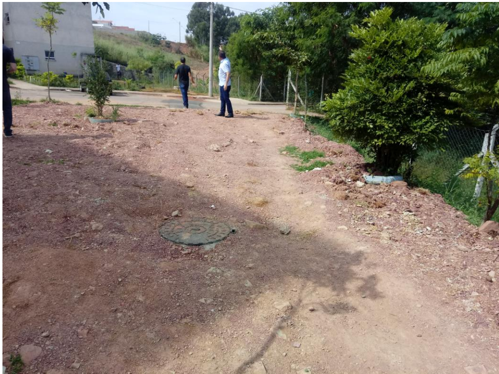
Figura 12 - Local onde foi instalada a nova rede de esgoto no interior do Condomínio
