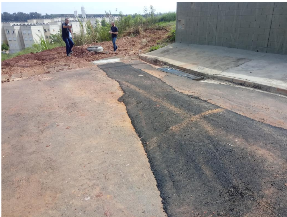
Figura 7 - Local (em frente a EEE Vem Viver) onde foi instalada a rede de esgoto até o condomínio
