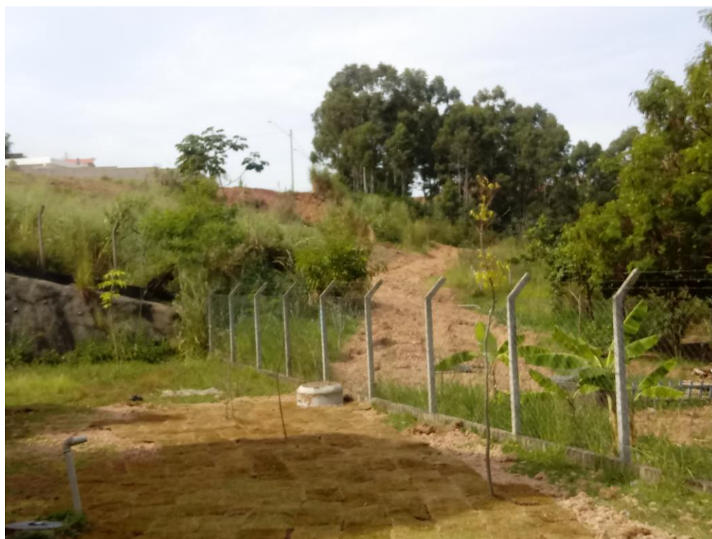
Figura 13 - Trecho (no interior do Condomínio) onde foi realizada a instalação da rede de esgoto (nota-se a grama recém plantada)
