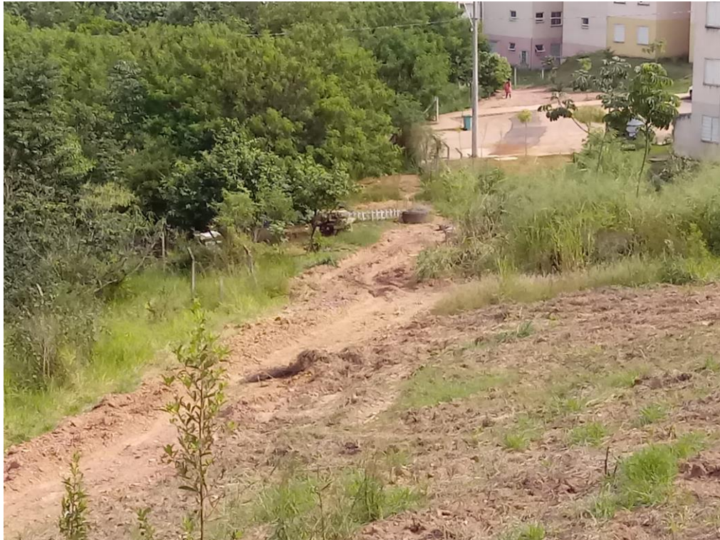
Figura 11 - Figura 10 - Trecho onde foi instalada a nova rede (nota-se aos fundos, o Condomínio onde a rede foi instalada)
