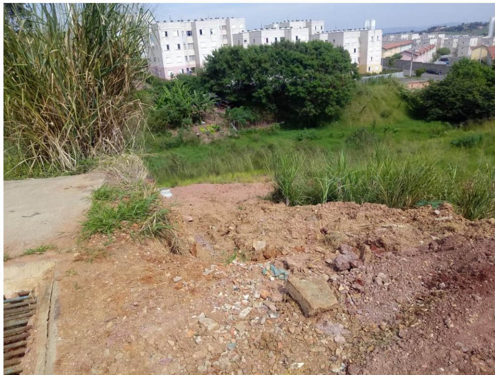
Figura 9 - Trecho onde foi instalada a nova rede de esgoto
