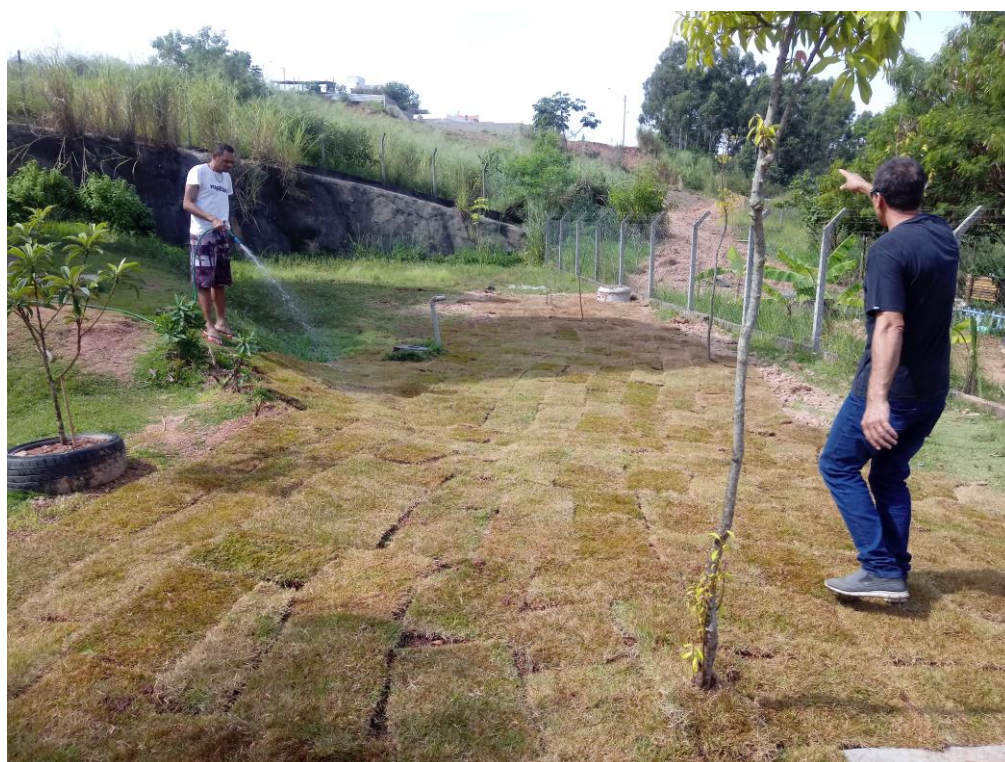
Figura 14 - Trecho (no interior do Condomínio) onde foi realizada a instalação da rede de esgoto (nota-se a grama recém plantada)
