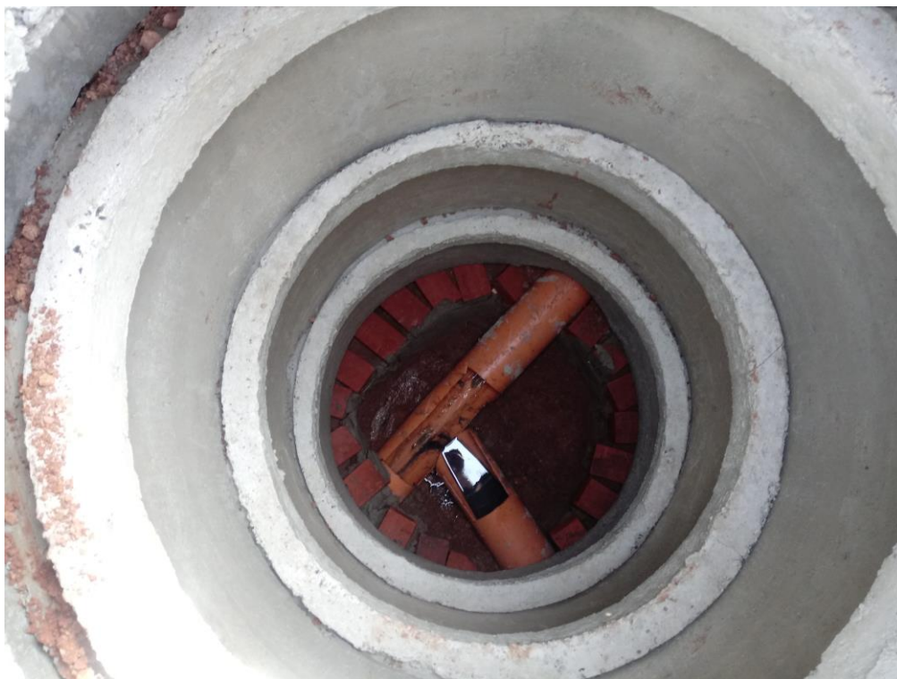
Figura 8 Poço de visita (recentemente construído) na rede até o condomínio
