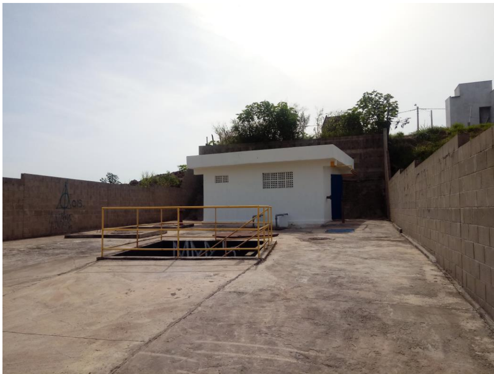
Figura 1 - Estação Elevatória de Esgoto do Bairro Vem Viver
